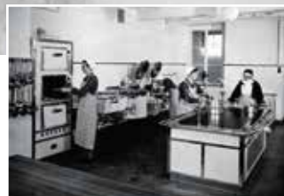
Instalación de una cocina en Kloster 1960
